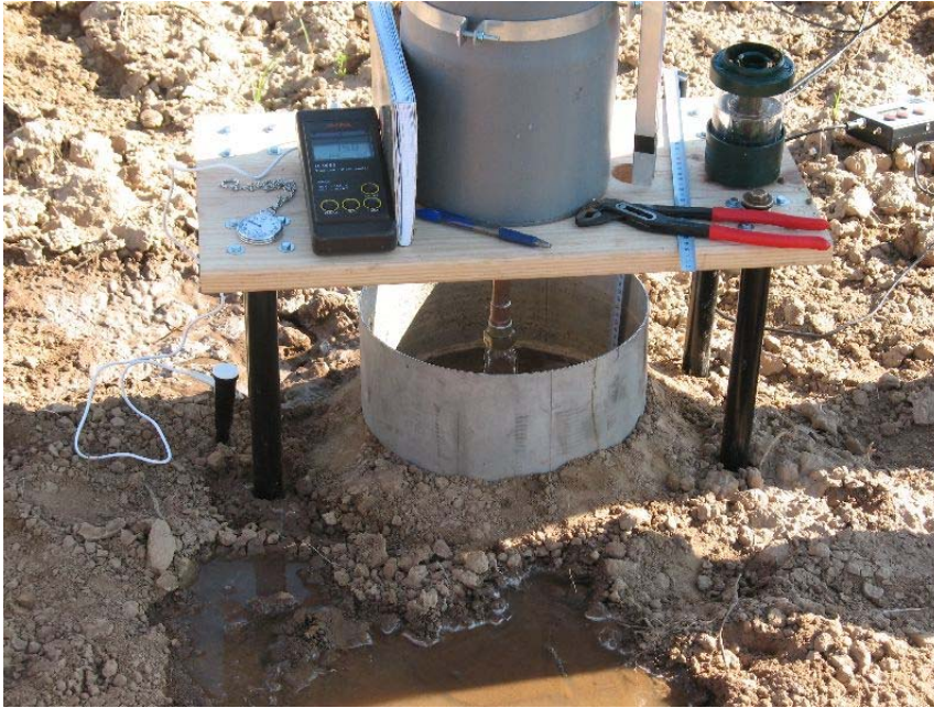
FIGURA 13. Varias horas de trabajo echadas a perder por la aparición de una fuga de agua. La única solución: cambiar de ubicación y volver a empezar
